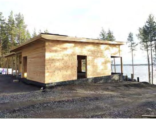
Hirsimökin perustukset sokkelielementeillä
