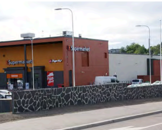
SLATE on luonnonreunaisella liuskekivellä verhoiltu kivelementti
