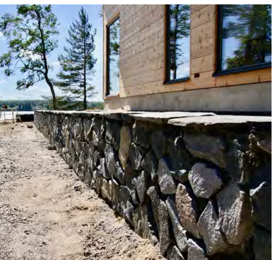
LOHKARE on suomalaisella lohkare-kivellä verhoiltu kivelementti
