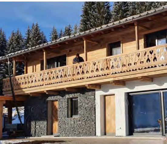
Mustanharmaalla lohkoreunaisella liuskekivellä pinnoitetut seinäelementit
