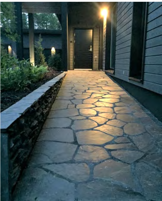
Liuskekivellä pinnoitettu invaluiska
