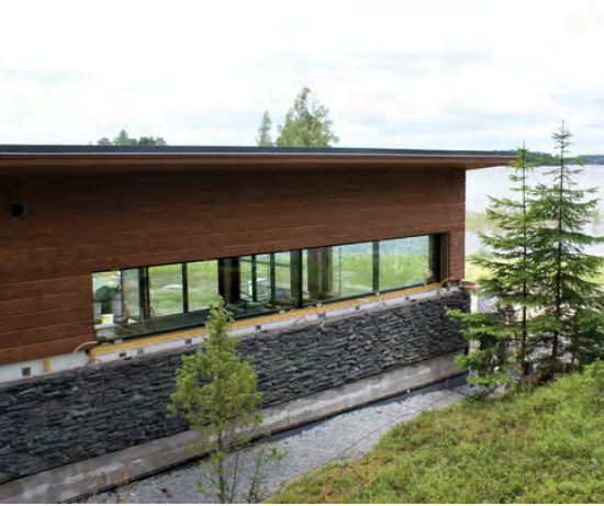
Stonelement-seinäelementit asennetaan tavanomaisesti perustuslinjan päälle
